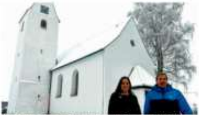
Verwaltungsbereich Johannes Ruth und Klaus Wolfenbender von der Kirchenverwaltung freuen sich über den Abschluss der Sanierung der Kirche in Bergenstetten. foto: Zhu Schmidt
